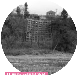
皆野町の護岸改修
